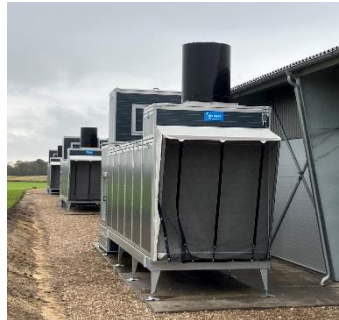
Foto 3 – 5. Tobias og Jette besøger DanHatch og ser på 2x3 varmevekslere fra Vencomatic Group/Rokkedahl Energi, installeret til fuld-ventilering i en ny skrabeægstald hos Rauff Hansen Agro.
