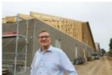
Jesper Knak er glad for, at Gråkjær ved stalden har fået udvidet deres erfaringer med at bygge farestalde med fursøgeløse, der bl.a. indholder flere typer linestil samt space-kit.
