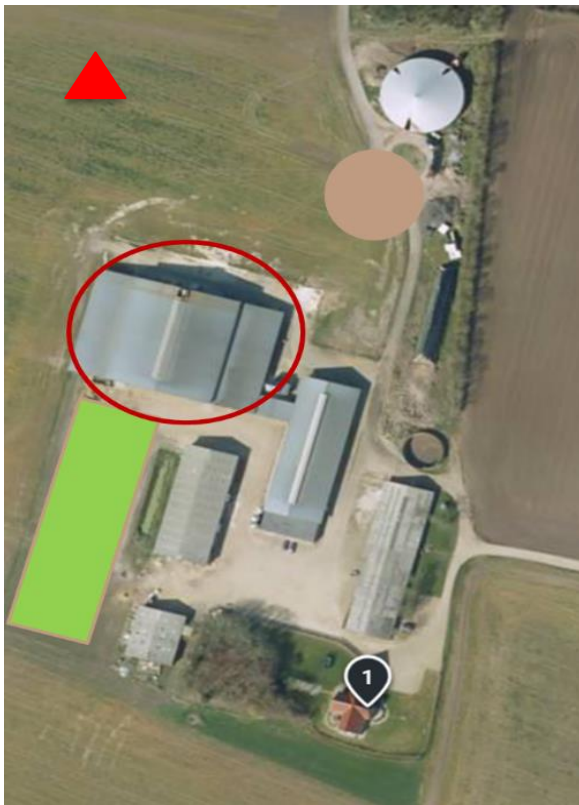
Figur 1. Teststalden er markeret med rød cirkel. Den nye stald (taget i brug i 2021) er markeret med grønt og ligger syd for teststalden. Den ene ikke-overdækkede gylletank ligger ved siden af en overdækket tank (nordøst for teststalden) – markeret med den brune cirkel. Den røde pil peger mod nord.
