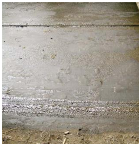
Figur 4. Gulvet kan i perioder blive glat grundet tør gødningshinde, der dækker profilering.
