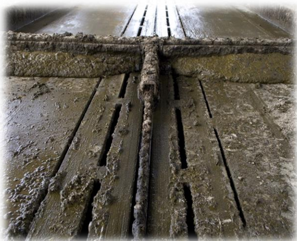
Figur 1. Kanalelement med spalter bortleder gødningen.
