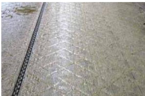
Figur 3. Gulvet er profileret med f.eks. harlekinmønster.
