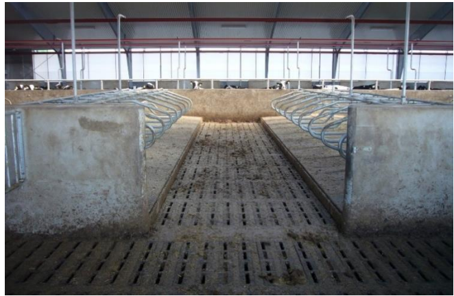
Figur 4. Element nedlagt i spaltestald.
