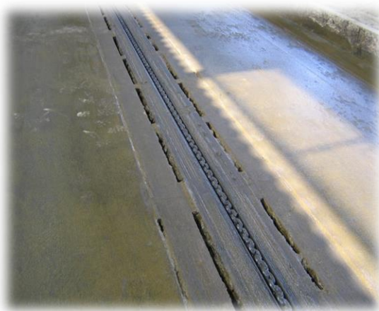
Figur 3. Rengjort gulv, men pas på udtørring.
