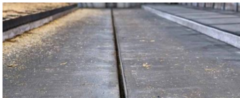
Figur 1. Gummibane med 3 % fald mod rende i midt af gulv. Til eftermontering på fast gulv eller spalter.
