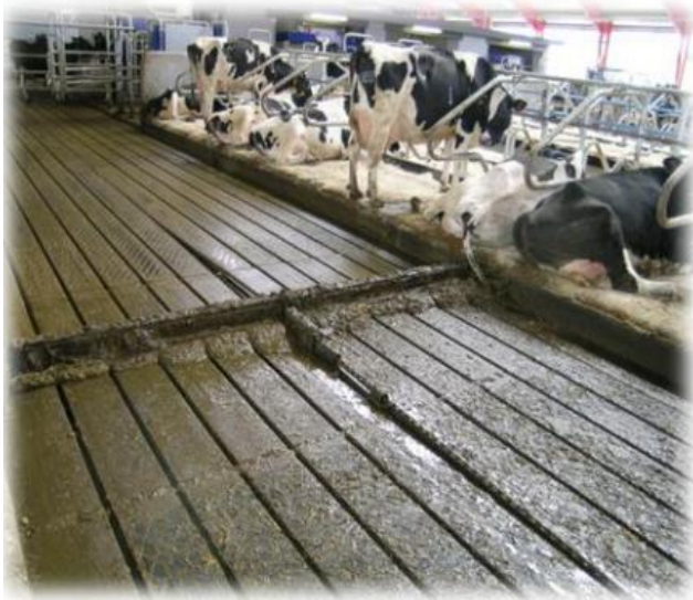
Figur 1. Indstøbt rilleprofileret gummibane.
