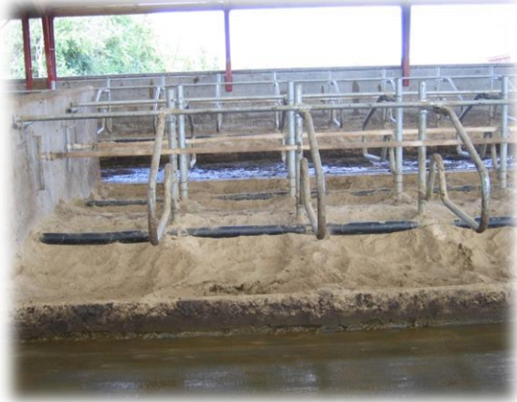
Figur 4. Sand skridsikrer gulvene.
