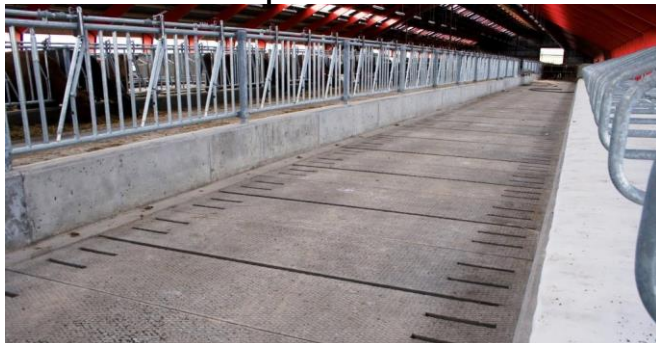
Figur 1. Drænelement med 1-3 % fald mod spalteåbning.
