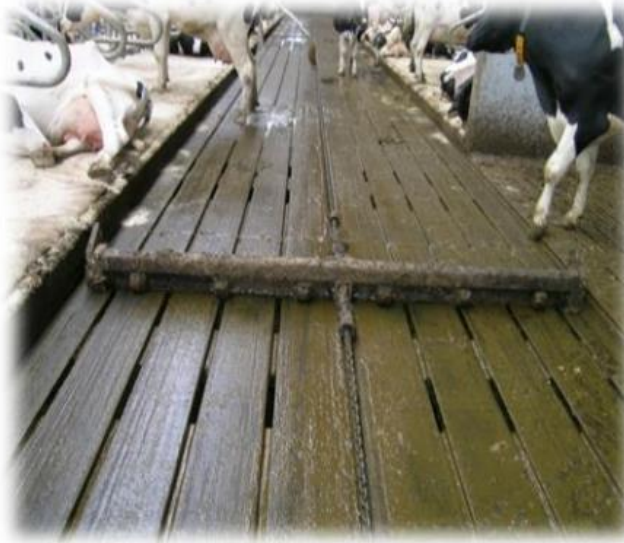
Figur 2. Langsgående afleveringsriller giver god skridsikkerhed.
