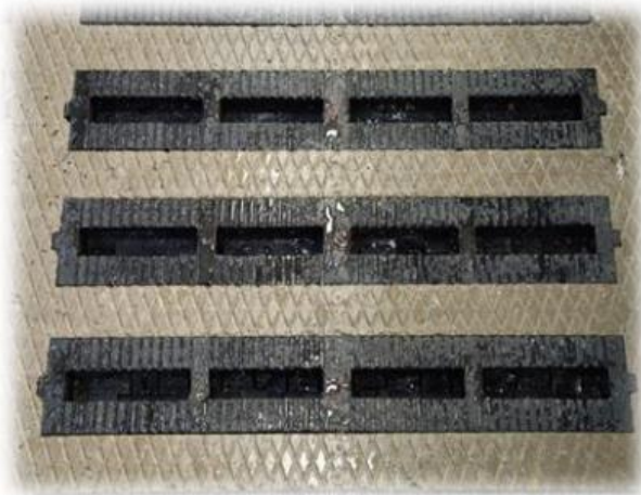
Figur 1. Spaltegulv med gummiindsats.
