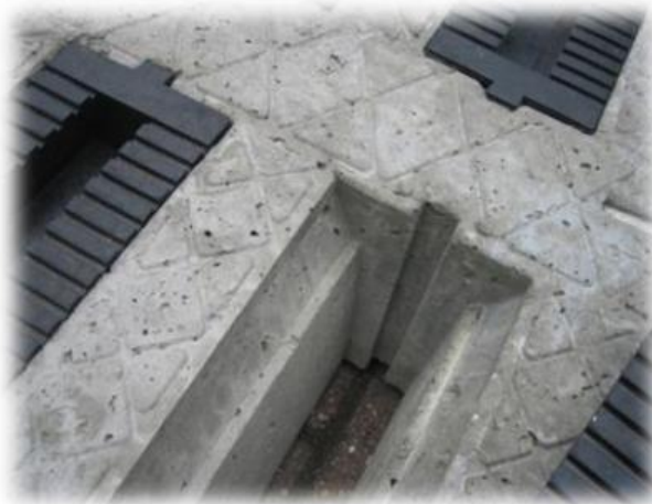
Figur 2. Gummiindsats kan udskiftes.
