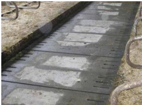
Figur 1. Elementer falder 1 % mod spalteåbning.
