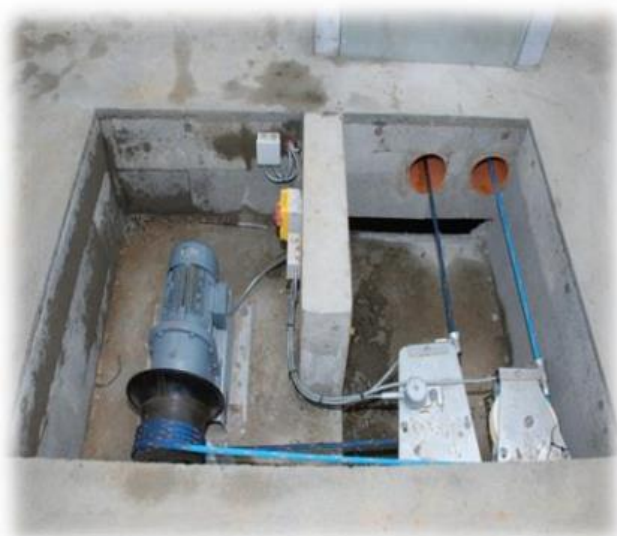
Figur 3. Trækstation til kanalskraber.
