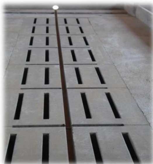
Figur 2. Kanalelementer lagt i serie.
