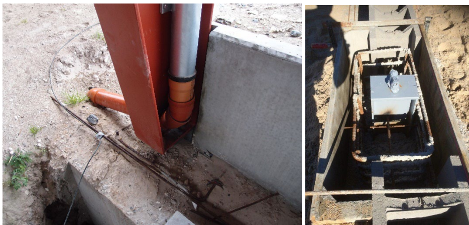
Billede 1: Eksempler på potentialeudligning i fundament, ført til stålspær og spærankre
