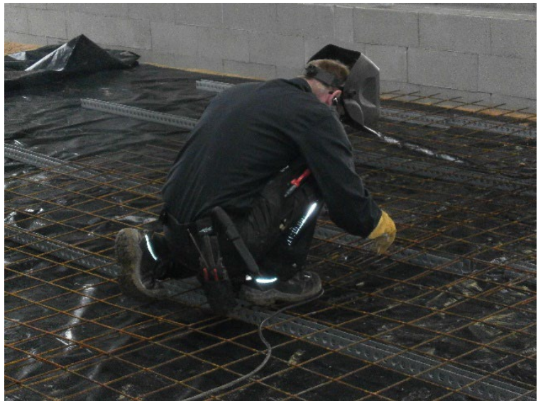
Billede 3: Armeringsjern svejses sammen inden støbning af gulv
