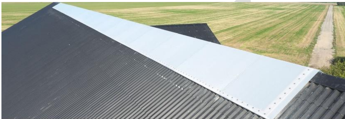
Billede 2. Løsning på tætning af lyskip fra Ivar Haahr (Foto: Ivar Haahr).
