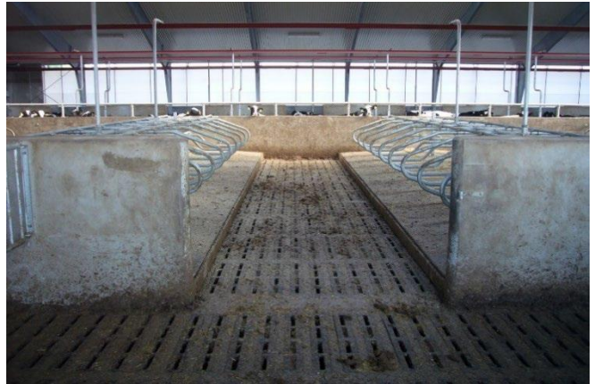
Figur 4. Element nedlagt i spaltestald.
