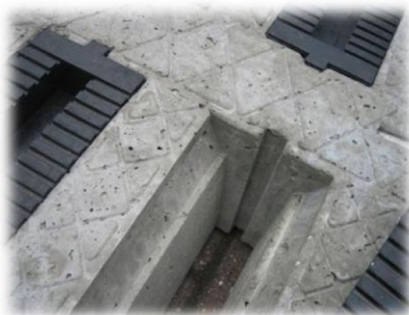
Figur 2. Gummiindsats kan udskiftes.
