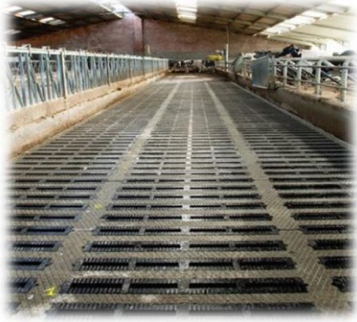
Figur 3. Kan nedlægges i eksisterende stald, såfremt hele spaltebjælken udskiftes med ny profil.
