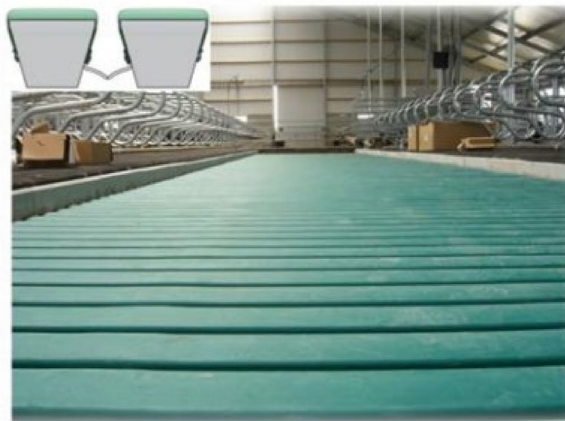
Figur 3. Overfladen er let buet.
