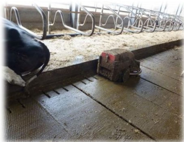
Figur 4. Spalteåbninger bag sengebåse.
