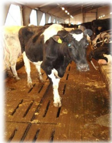
Figur 1. Godt renholdt kanalelement.
