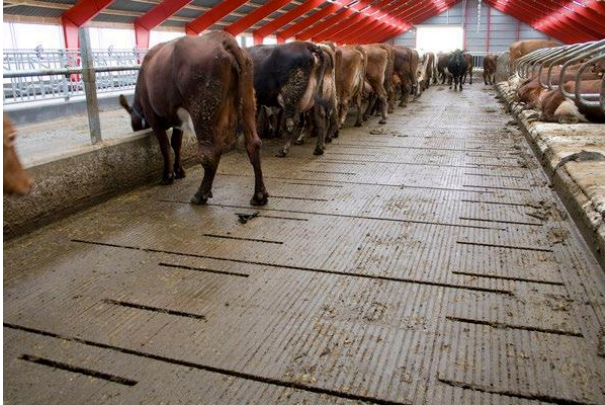
Figur 2. Gulvet er rilleskåret for at opnå bedre skridsikkerhed.
