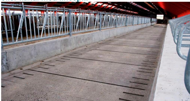
Figur 1. Drænelement med 1-3 % fald mod spalteåbning.
