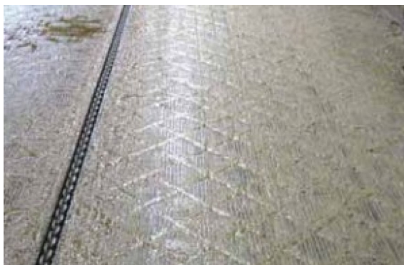
Figur 3. Gulvet er profileret med f.eks. harlekinmønster.
