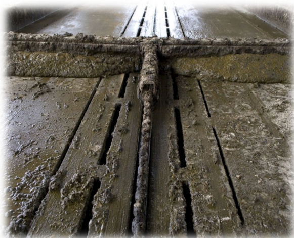
Figur 1. Kanalelement med spalter bortleder gødningen.
