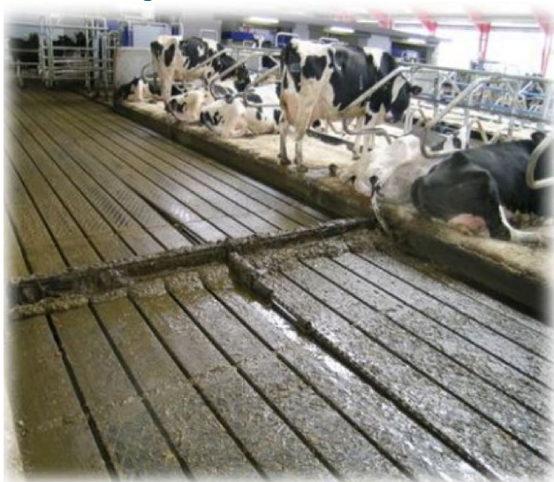
Figur 1. Indstøbt rilleprofileret gummibane.
