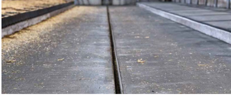
Figur 1. Gummibane med 3 % fald mod rende i midt af gulv. Til eftermontering på fast gulv eller spalter.
