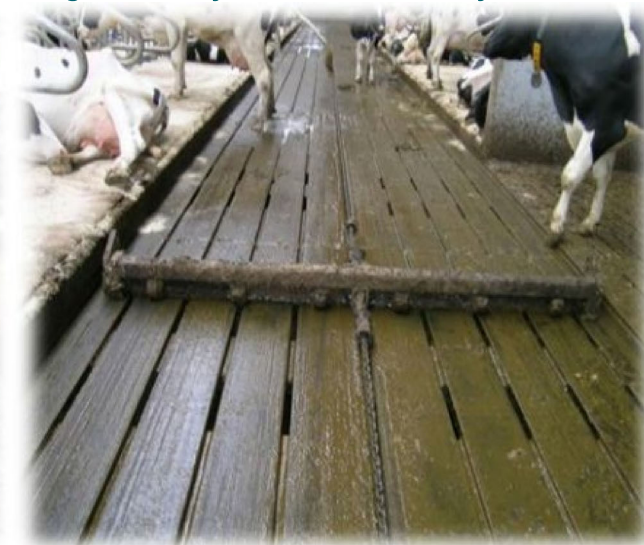
Figur 2. Langsgående afleveringsriller giver god skridsikkerhed.
