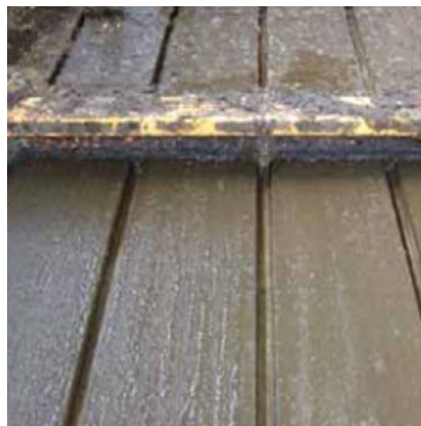
Figur 2. Skraber på gulv har "fingre" som skraber spalterillen effektivt.
