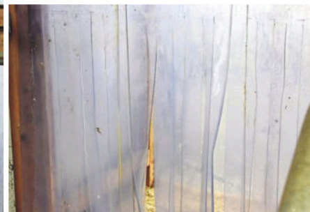
Dobbelte lameller af plastik har vist sig at være effektive til at holde metanhuset mest mulig tæt og samtidig har køerne lyst til at stikke hovedet igennem. Fotos: Peter W. Mogensen
