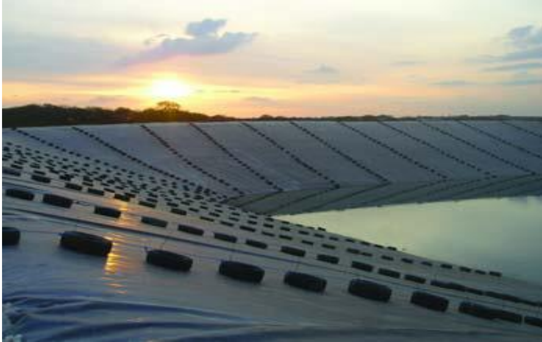
Vandreservoir med membran i England
