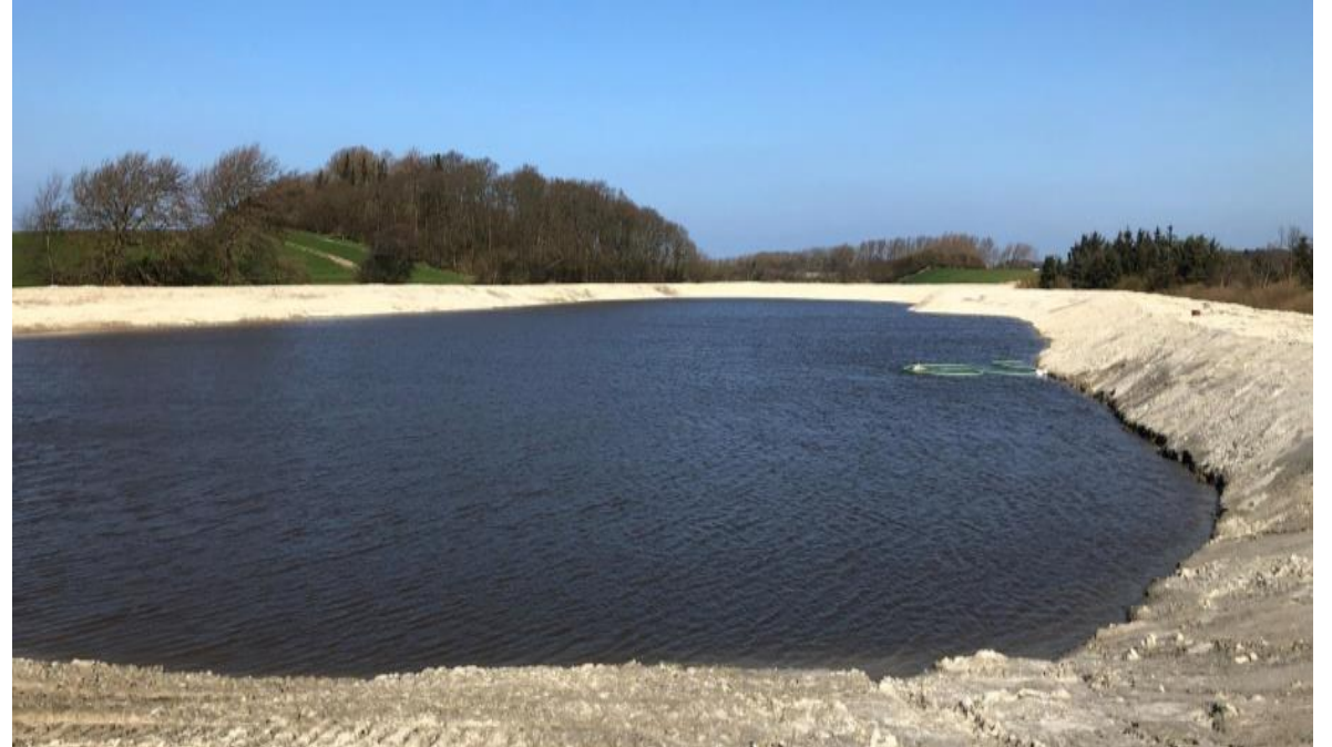
Nybygget vandreservoir uden membran
