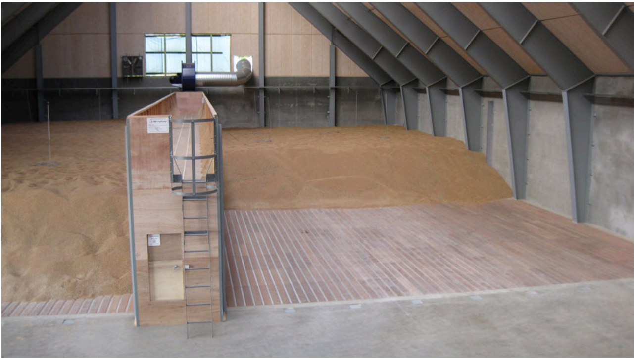
Billede 2. Planlager med kørefast gulv. Foto: Sukup Europe.
