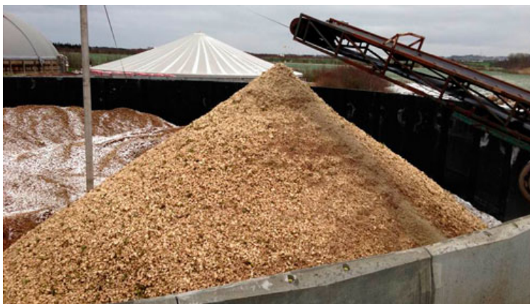
Silo, som er etableret ved Grøngas i Vraa. Da pH i roemassen er meget lavt, det vil sige under 3,5, skal beton sikres mod tæring. Her er silovæggen påført et lag plastik og herefter et lag syrefast. Foto: Jens Peter Lunden, Grøngas, Hjørring.
