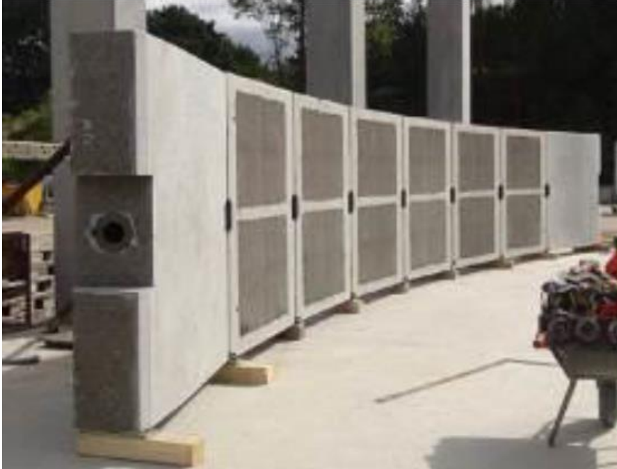
Figur 6: Elementer står på siden og er klar til at få støbt samlinger og blive spændt op.
