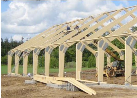
Billede 2: Eksempel på spær udført i limtræ. Foto: Flexwood
