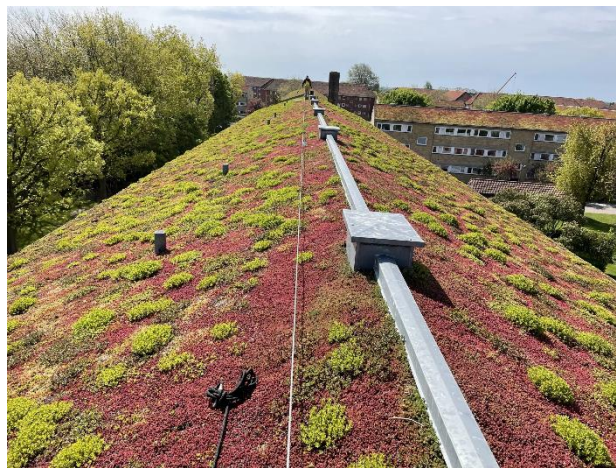
Billede 3: Eksempel på Sedumtag. Foto: VegTech A/S
