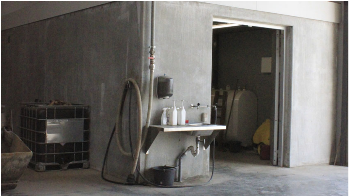
Billede 3. Indretning af indendørs fyldeplads kombineret med rengøring i marken minimerer behovet for opsamling af vaskevand.
