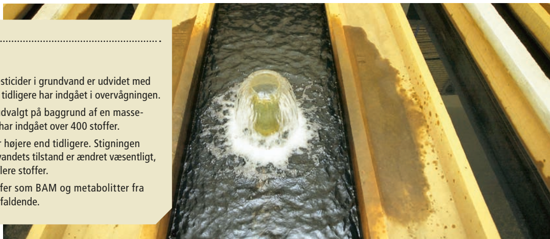
For-filtrerings-anslæg på Kolding Vandværk.
