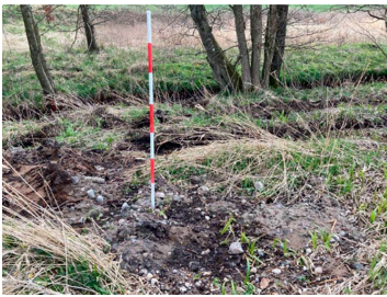
Billede 2: Opgravet sten og grus fra bunden af vandløbet. Kun aflejret materiale som sand og slam må fjernes ved vedligehold.
