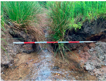
Billede 3: Bundbredden er gravet ca. 3 gange større end tidligere. Vedligeholdelse må ikke ændre vandløbets skikkelse eller vandføringsevne.
