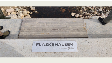
Billede 3. Diget "Flaskehalsen" har fået sit navn på grund af røret, der går gennem diget. Her fungerer røret som en flaskehals for åens vand. Store mængder regn vil resultere i, at vandet opmagasineres på de lave arealer øst for diget fremfor at fortsætte videre til Kolding Å og Kolding Centrum. I forbindelse med projektet er der lavet siddepladser på diget, så det er muligt for områdets brugere at nyde udsigten og holde kaffepause. Foto: Rikke Krogshave Laursen / Line Bønnelycke Nørgaard, SEGES Innovation.
