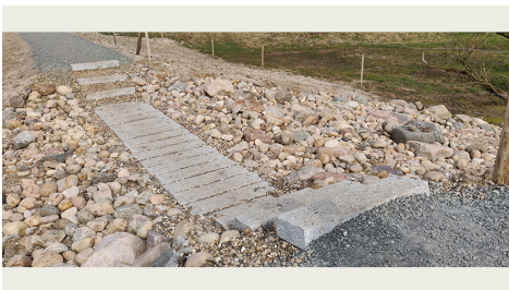
Billede 4. Overløb ved det østlige dige. Når diget her er fyldt op med vand, vil vandet risle over stenene, hvorefter det vil stuve op bag det næste dige. Foto: Rikke Krogshave Laursen / Line Bønnelycke Nørgaard, SEGES Innovation.
