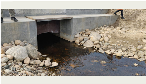
Billede 2. Det østlige dige ved Hylkedalen, også kaldt "Flaskehalsen". Her ses det, at røret er dimensioneret således, at der forsat er fri passage for smådyr og fisk. Når vandet fra vandløbet står højere end jernpladens nederst kant, så opstuvendes vandet bag diget. Foto: Rikke Krogshave Laursen / Line Bønnelycke Nørgaard, SEGES Innovation.
