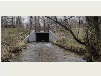
Billede 1: Dige og bygværk med vandbremse set fra nedstrøms retning. Foto: SEGES Innovation.
