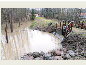
Billede 6: Rathlousdaldæmningen i fuld aktion. Her ses hvordan vandet støver op bag diget og der oversvømmes bagud i systemet, februar 2022. Foto: Odder Kommune.
