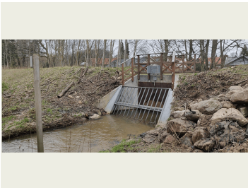
Billede 2: Dige og bygværk med vandbremse med gitterforanstaltning til at bremse grene, blade og andre store genstande, som transporteres i vandløbet, og herved undgå tilstopning af udløbsprofilet, set fra opstrøms retning. Til venstre på billedet ses bagsiden af pejlestationen dæmningen, som er en del af varslingsystemet. Live data fra pejlestationer er offentligt tilgængeligt via http://odder.web4you.dk/ Foto: SEGES Innovation.
