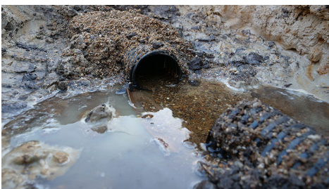
Billede 9: Nøgenrør + filtergrus med gravemaskine og drænkasse, fiberdug under. Her var gruset mere grovkornet, og der var derfor trængt hverken filtergrus, finsand eller okker. Dog var der trængt rødde fra forrige års raps ned i rørene. Foto: Martin Stoltenberg Hansen, SEGES Innovation.
