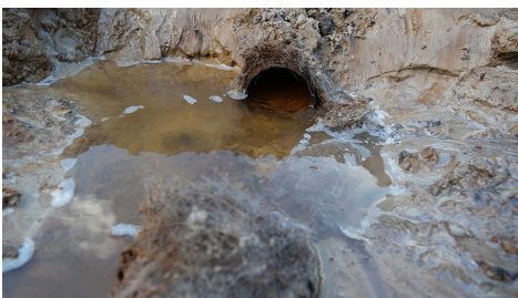
Billede 5: PP700 L-plov. Der blev observeret til mere okker i røret, men ikke i mængder der er problematiske. Ingen sandindtrængning. Foto: Martin Stoltenberg Hansen, SEGES Innovation.
