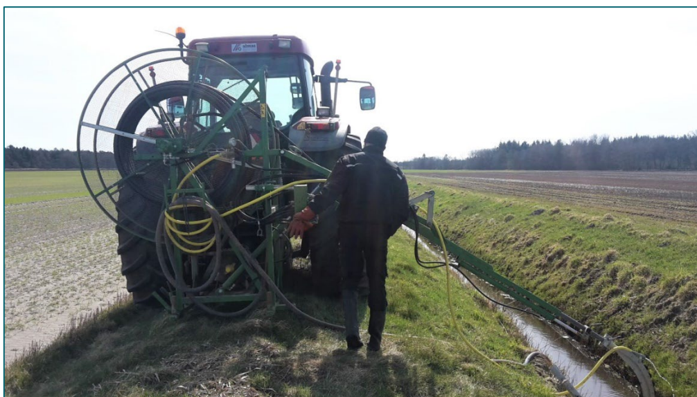
Figur 13. Spuling af drænrør i praksis (Foto: Stinna Susgaard Filsø).
