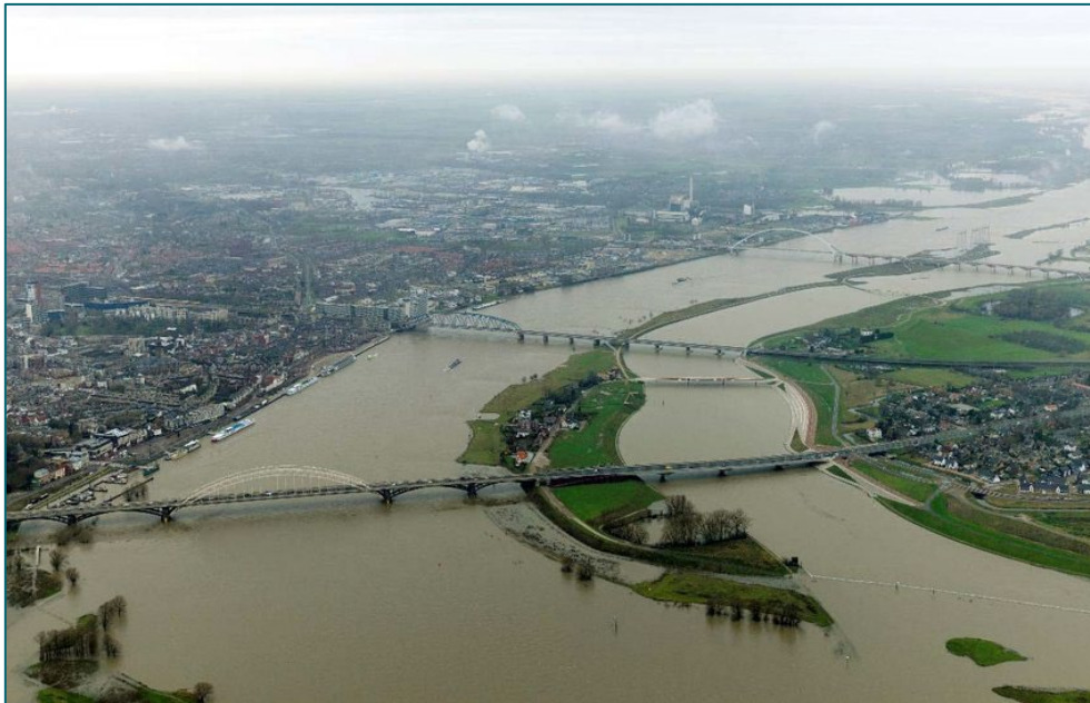
Figur 4. Billede af det etablerede omløb (til højre) i floden Waal ved Nijmegen (Foto: RWS).
