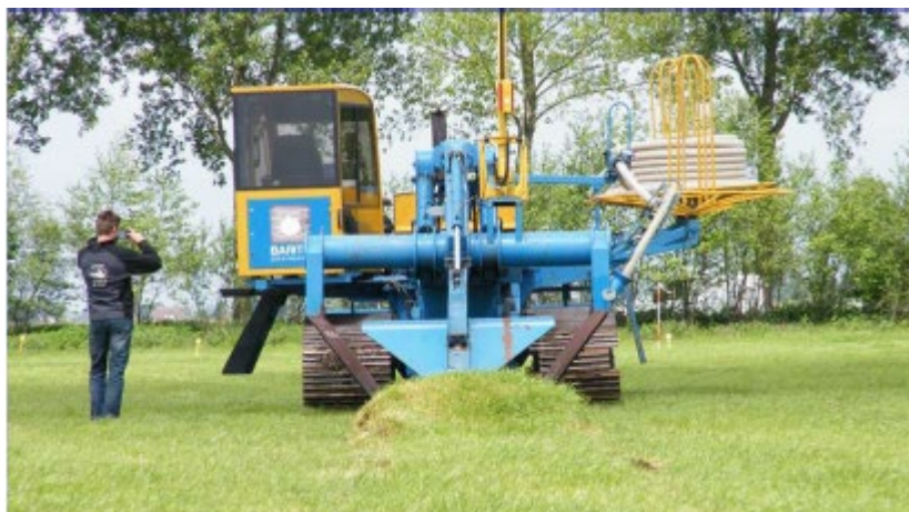
Fig.1 Ilægning af dræn til kontrolleret vandniveau. Det er intentionen at vand kan pumpes tilbage til marken når vandniveauet falder for meget.
