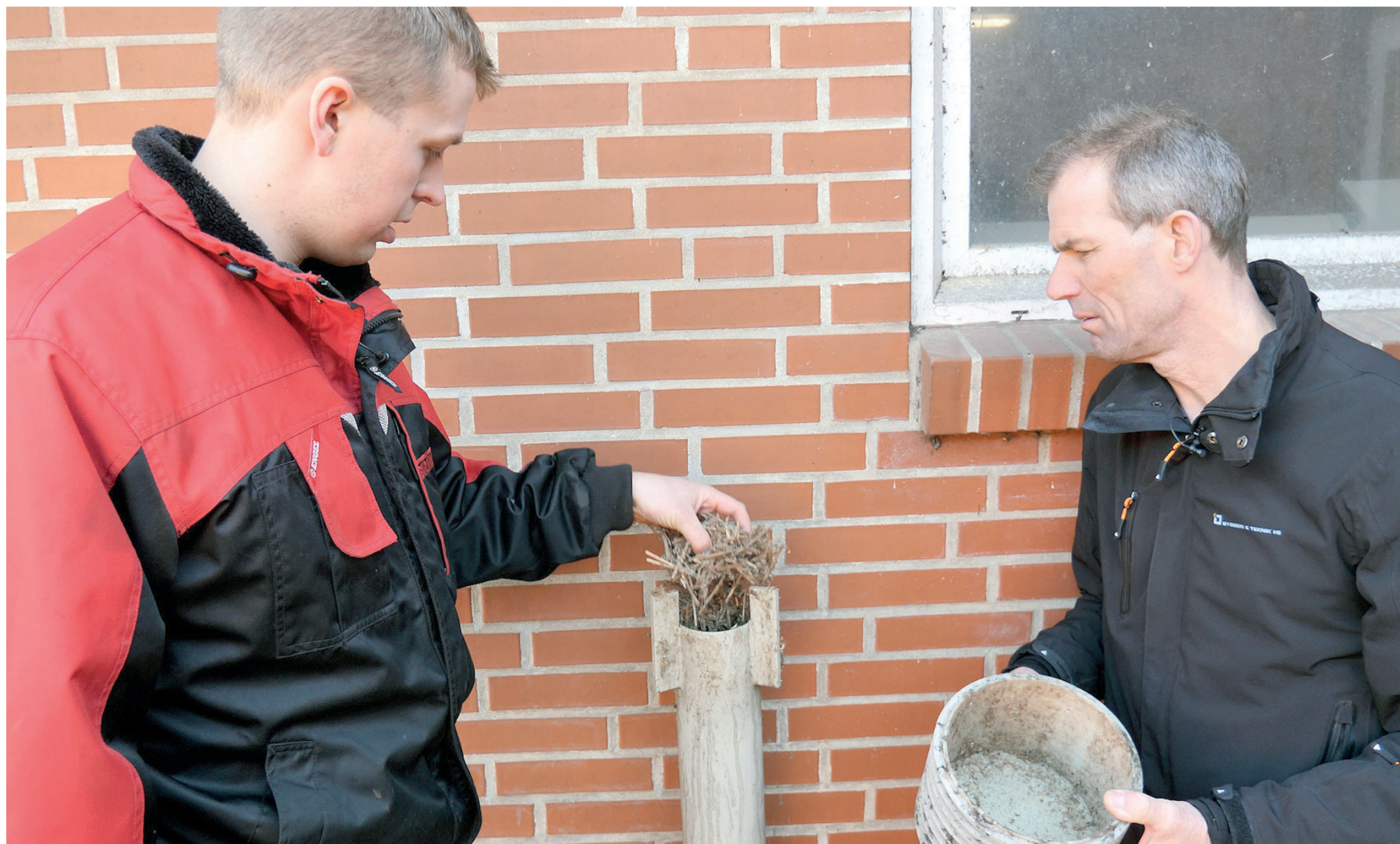
■ Her tjekkes udvendige luftkanaler for skidt af Martin Rohde Andersen, medarbejder på Skovlygaard (tv) og Kurt Mortensen, rådgiver hos Byggeri & Teknik.
