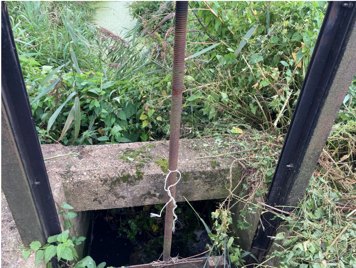
Figur 7: Reguleringsmekanisme som var installeret i dræning/vandingskanalerne i området omkring Willow Hall Farm. Installationen virkede som en dæmning, hvor man kunne regulere vandhøjden alt efter behov Billede: Majken Deichmann, SEGES Innovation
