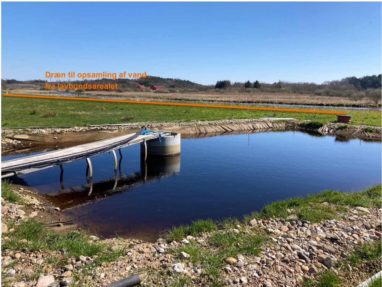
Figur 4: Indvindingsbassin ved filteranlæg i Vejrumbro. Bemærk den orange linjer indikerer nedgravet dræn som leder vand fra forsøgs arealet til vandindvindingsbassinet. Denne løsning er anvendt i forsøget da der ikke måtte ske påvirkning af de andre forsøg på arealet. Det forventes ikke at denne løsning vil kunne etableres i virkelige vådlægningsprojekter hvis der ikke findes et eksisterende dræn som kan anvendes til at lede vand til anlægget.
