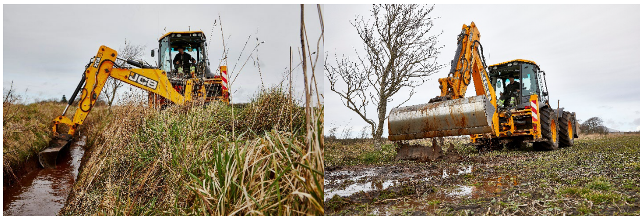
Figur 7: Sediment fjernes fra vandløb for at opretholde vandløbets afvandingsevne. Arbejdet udføres med en rendegraver. Foto: Landbrugsmedierne, 2020.
