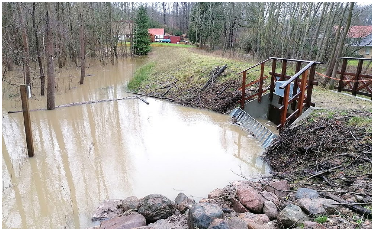
Figur 21: Rathlousdaldæmningen i Odder tilbageholder omkring 32.000 m 3 vand. Foto: SEGES Innovation.
