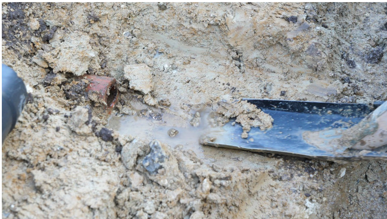
Figur 24: Gamle drænrør af tegl har generelt en lang levetid, men nogle gange er det nødvendigt at kigge på om de skal optimeres, enten som følge af skader, underdimensionering, sætninger af jorden, tilstopninger eller noget helt andet. Her blev der koblet plastikdrænrør (som kan anes til venstre) på det gamle drænsystem, for at udvide det drænedes areal. Foto: SEGES Innovation.
