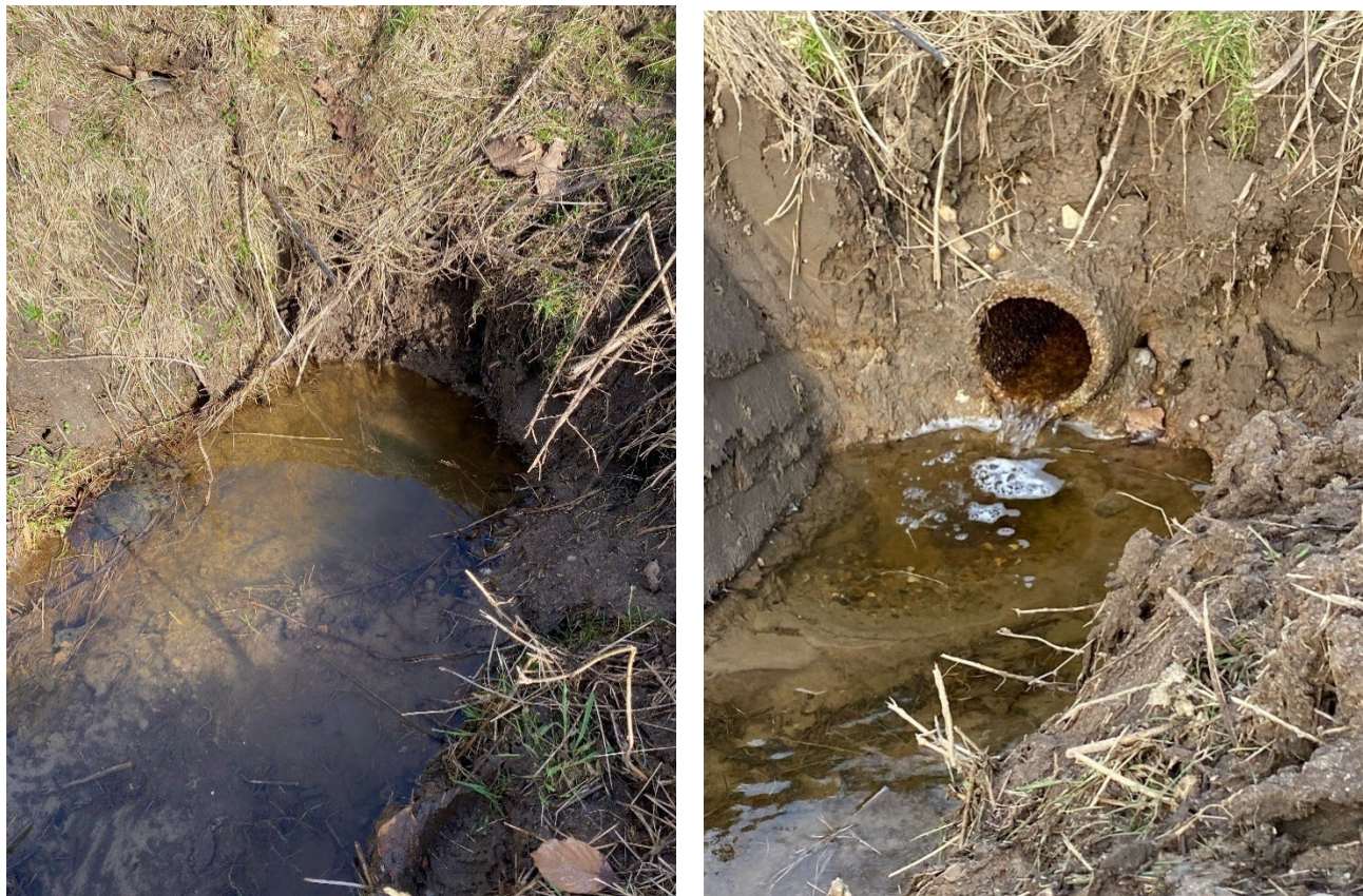
Figur 6: Det samme rørdøb før (tv.) og efter (th.) oprensning. Foto: SEGES Innovation, 2024
