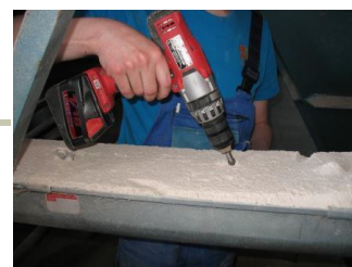
Akku boremaskine afmonterer skærm over U-rende.
