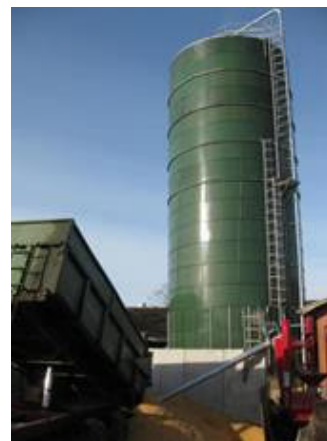
Ved lagring i gastæt silo vil majsens fermentere og siloen skal derfor være udført i rustfrit stål, glasemaljeret eller med coated overflade.
