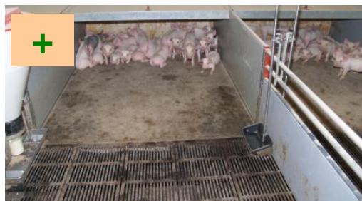
Fast gulv under overdækninger og tætte overdækninger
