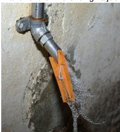
En simpel måde til gennemskylning af rør
