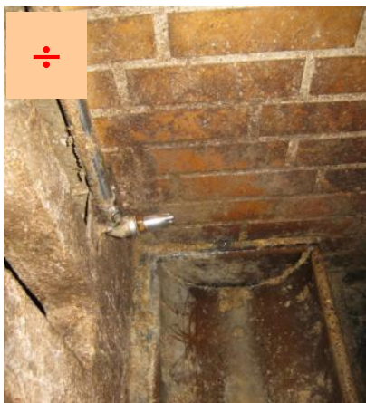
En simpel måde til gennemskylning af rør
