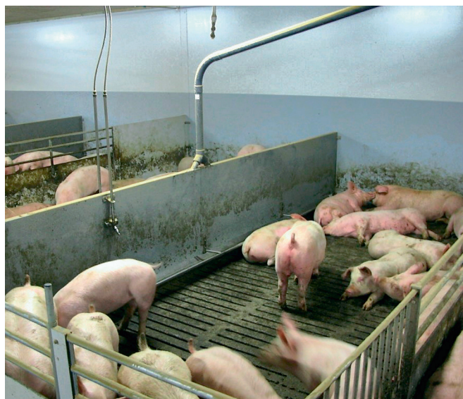
Slagtegrisestald med punktudsugning under det drænedes gulv.
