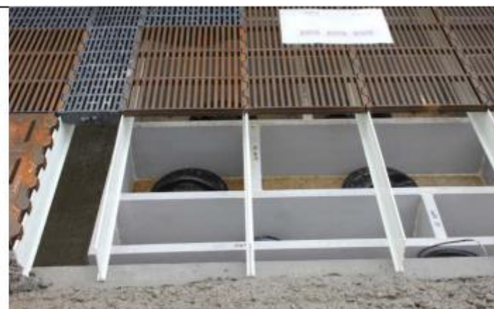
Figur 4. Gødningsopsamlingsbakke placeret under spaltegulvet.
