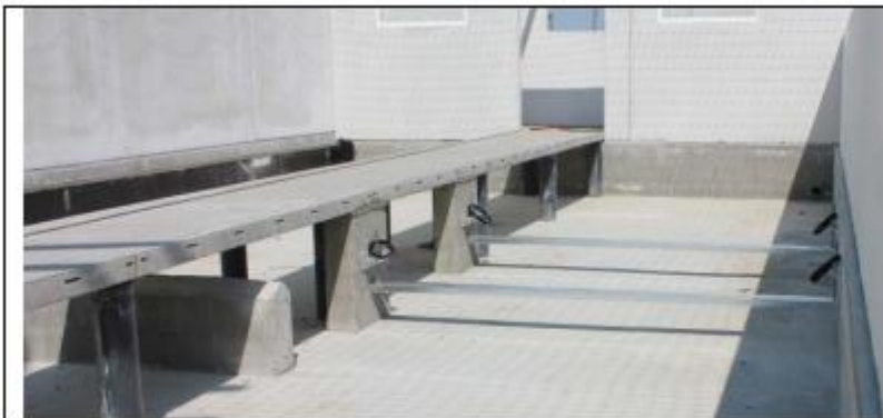
Figur 1. Vejeceller i gyllekanal før montering af gødningsopsamlingsbakke.
