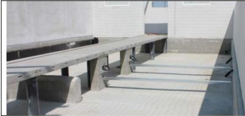
Figur 1. Wejceller i gyllekanal før montering af gødningsopsamlingsbakke.
