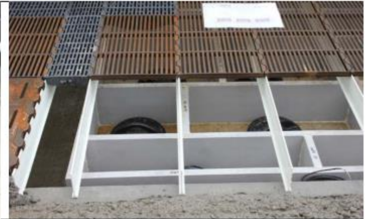
Figur 4. Gødningsopsamlingsbakke placeret under spaltegulvet.
