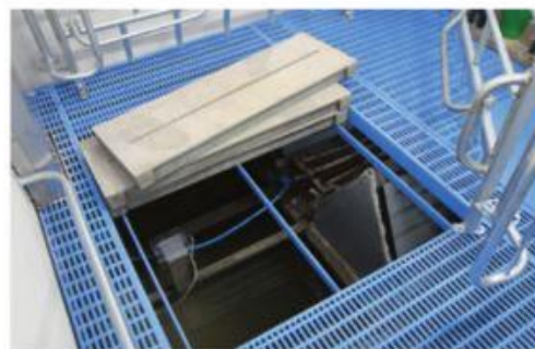
I to af fire sektioner er opført linespil med forskellige bunde. Der er en sektion med gylletrage og en traditionel bund i en sektion. Foto: Søren Tobberup Hansen.
