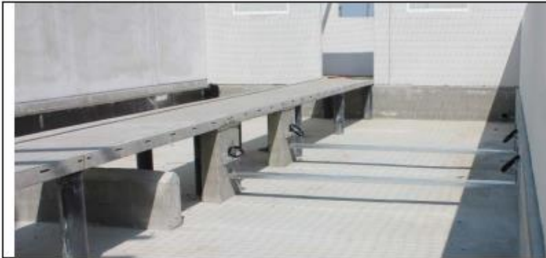
Figur 1. Wejceller i gyllekanal før montering af gødningsopsamlingsbakke.
