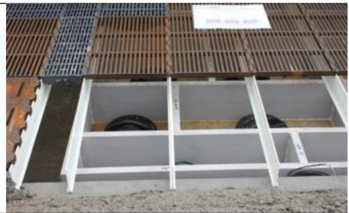
Figur 4. Gødningsopsamlingsbakke placeret under spaltegulvet.
