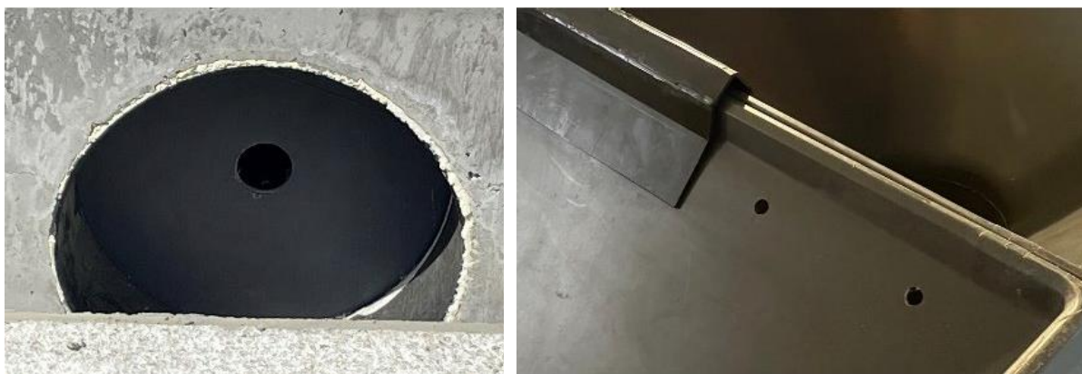
Figur 5 TV. 110 mm ventilationshul mellem central ventilationskanal og SpaceKit kassetter. TH. 2 af de 5 stk. 25 mm ventilationshuller, samt del af dækplade.
