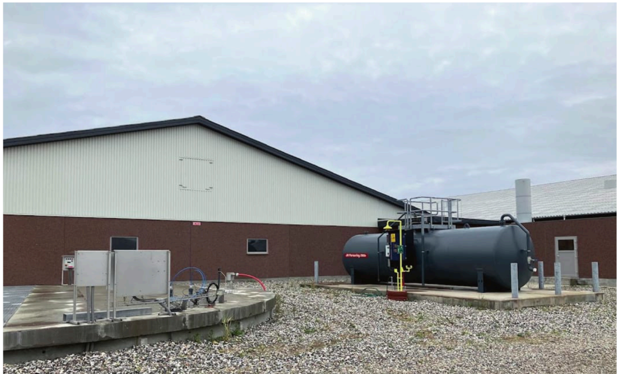
Forsuringsanlægget set ude fra staldbygningen.
