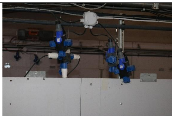
Figur 7. Opsætning af ekstra stik til strømforsyning
