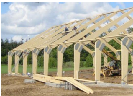
Figur 6. Eksempel på spær udført i limtræ. Foto: Flexwood
