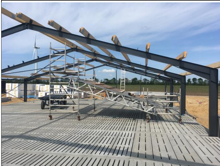
Figur 5. Stålspær i en Konceptstald.
