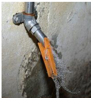
En simpel måde til gennemskylning af rør.
