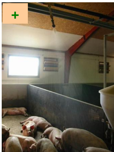
Korrekt placeret overbrusning med fladdyser.
