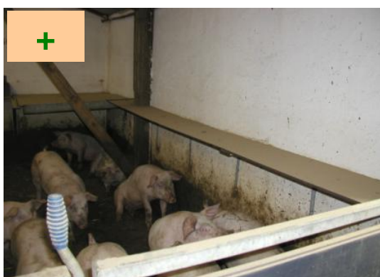
Pkt. 5. Prelleplade på væg.
