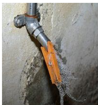
En simpel måde til gennemskylning af rør.
