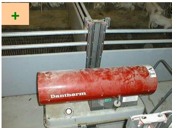
Udtørring med varmekanon.
