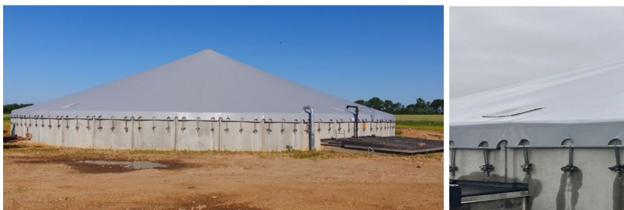
Figur 2 - Billede af Tank B med special teltoverdækning. De kvadratiske luger kan ses på billedet til højre.
