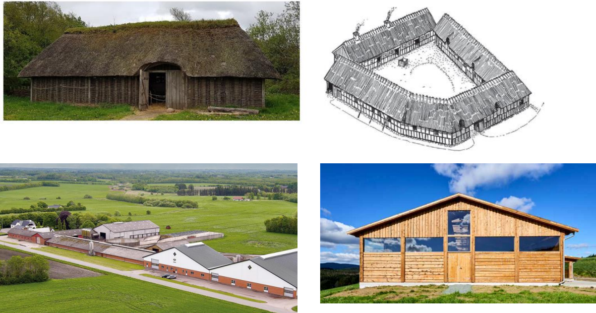
Figur 14. Ø.tv. Staldbygning fra middelalderen med pileflettet facade og trækonstruktion. Dyr og mennesker under samme tag. Ø.th. Gård fra renæssancen/barokken bygget med stråtag og større trækonstruktioner. Tv. Nutidig produktionsanlæg i beton og stål. Th. Kostald fra Norge som er bygget af træ fra egen skov. Kilde Pluskontoret Arkitekter.
