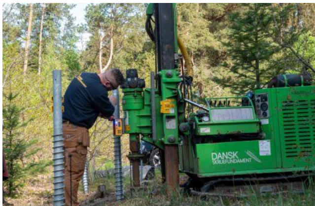
Figur 6. Etablering af skruefundament. Kilde Dansk Skruefundament.
