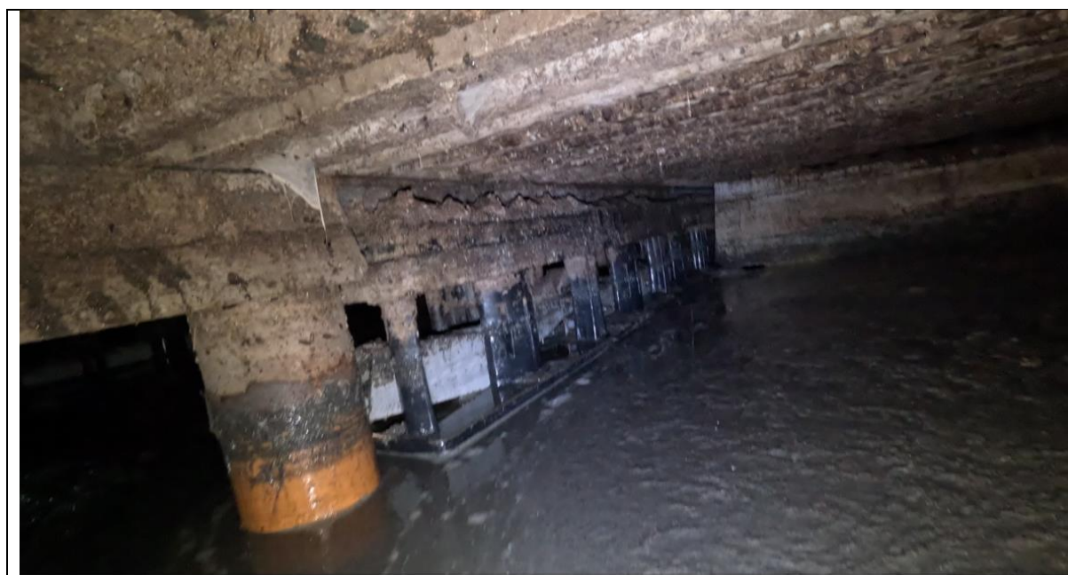
Figur 4. Plastkanalelementerne placeret i gødningskummen. Billedet er taget efter tre års brug under en gylleudslusning.
