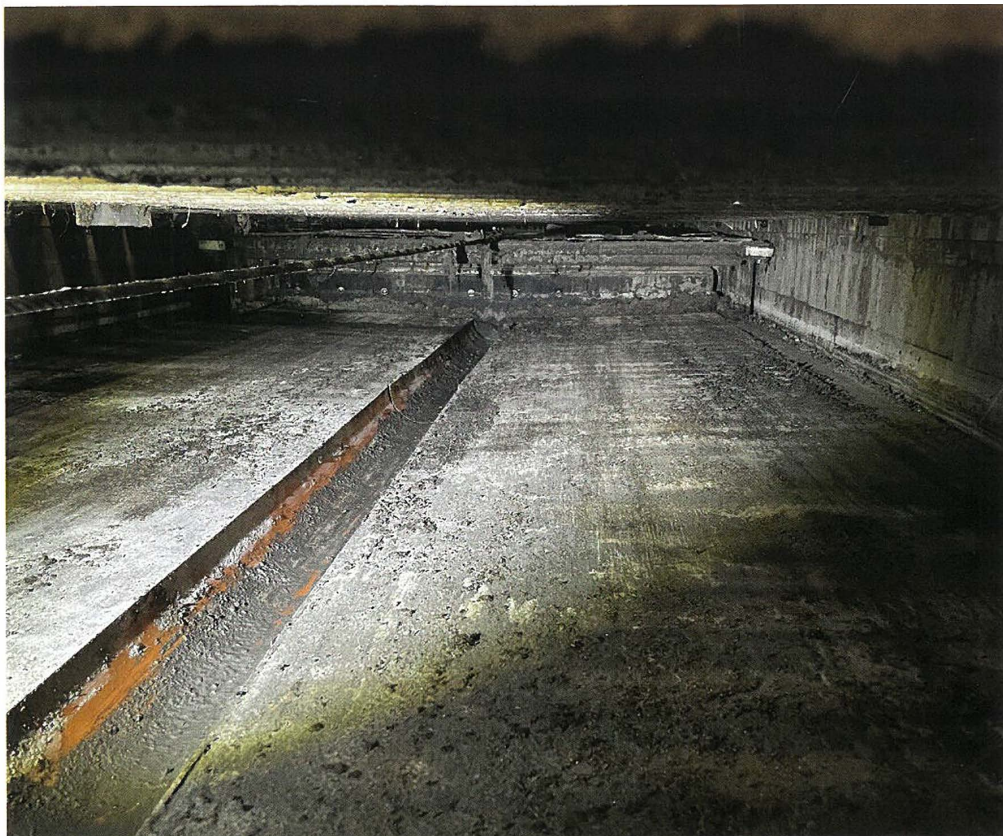
Skrabekanalen har skrå skrabeblader med en hældning på fem procent ind mod ajlerenden
